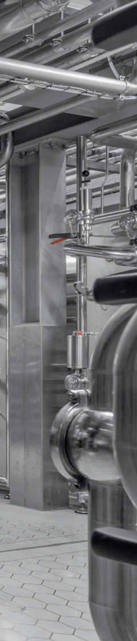
KIESELMANN Edelstahlventile: höchste Qualität in Maßhaltigkeit und Oberflächenbeschaffenheit. Alle verwendeten Dichtelemente haben die für die Lebensmittelindustrie nötigen Zulassungen. Der modulare Aufbau unserer Ventile ermöglicht es, schnell und einfach von einem Handhebel auf einen pneumatischen Antrieb mit Sensoren oder Steuerkopf umzustellen.
