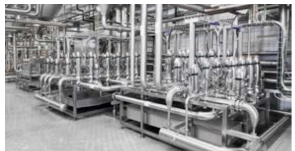
Drucktankkeller: von manueller zu automatisierter Steuerung – im Keller wurde die Paneeltechnik durch Doppelsitzventilknoten ersetzt.
