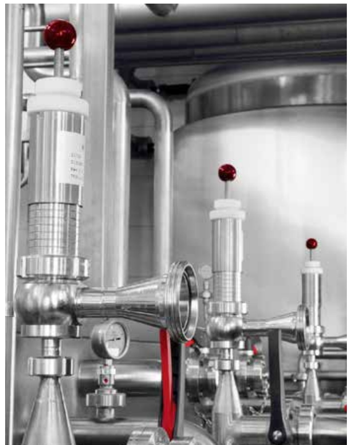
Spundventil an einer KZE für Bier
