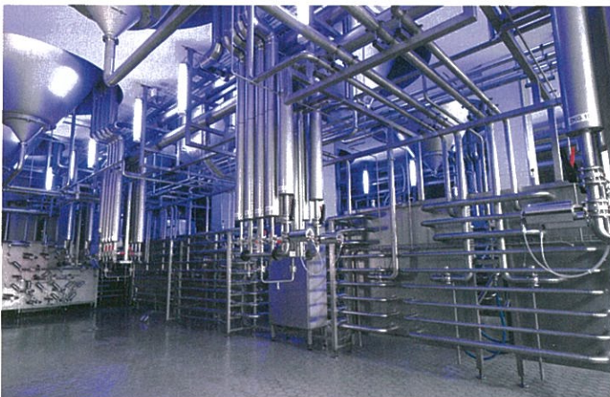
Rückansicht des Rohrzaunes im ZKL-Keller
