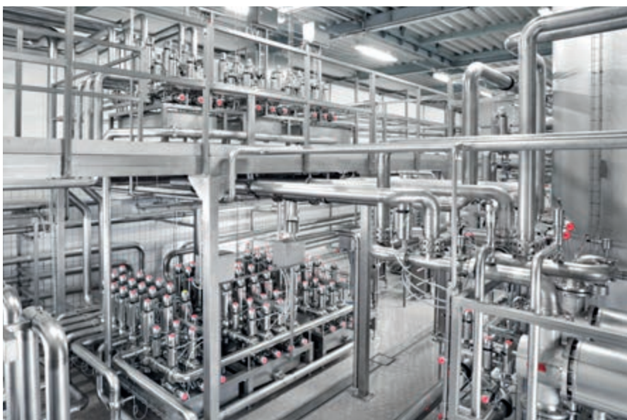
Doppelstöckiger, vollautomatischer Ventilknoten mit DN125/100 vermischungssicheren Doppelsitzventilen, um zehn Tanks auf sieben Abfülllinien zu schalten.
